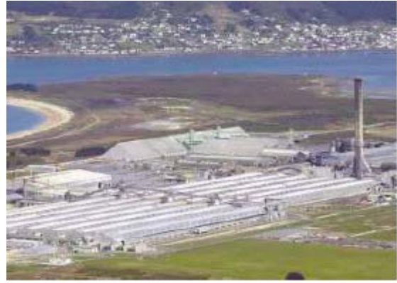
Rio Tinto Group – Comalco металлургическое производство алюминия. Плавный пуск для вентиляторов и шаровых мельниц.
